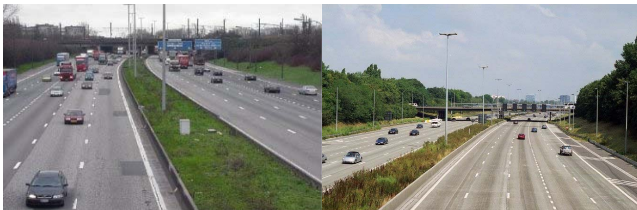
Figure 2 – Vues sur le Ring avant et après les travaux
