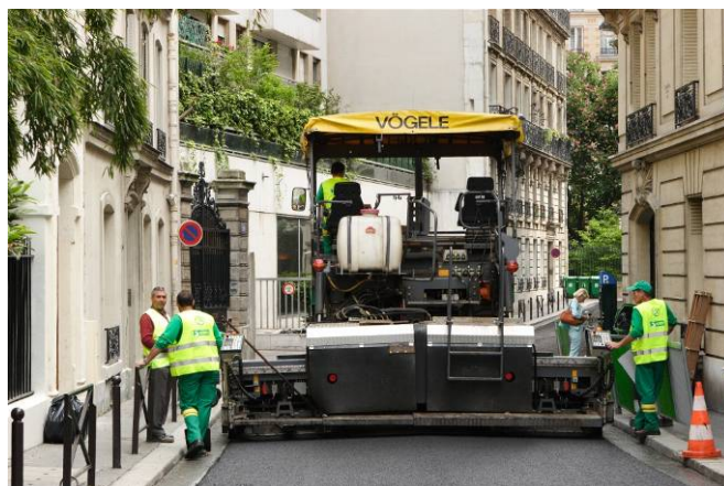
Photo 2 - Une gêne réduite pour les riverains.
