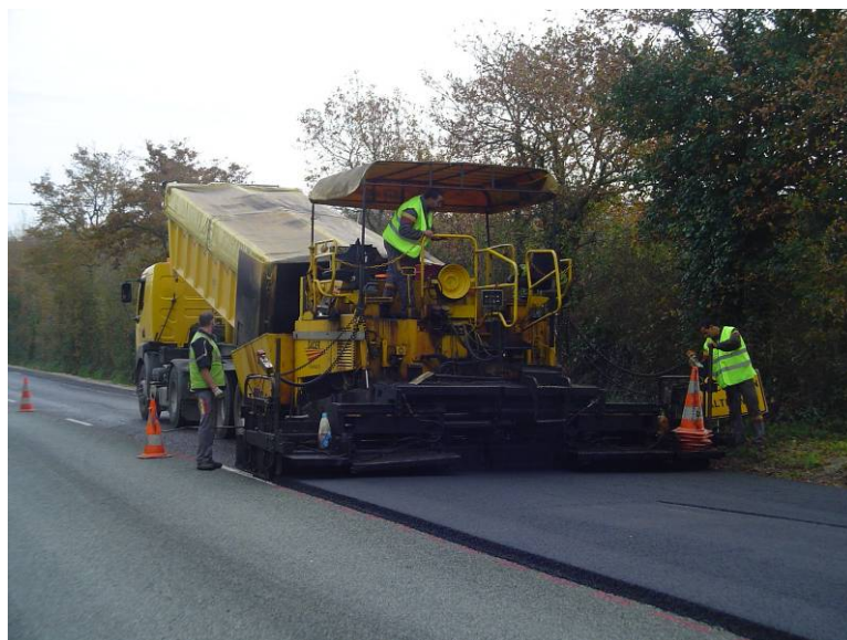
Photo 1 - Chantier du RD 2160, Atelier de mise en œuvre
