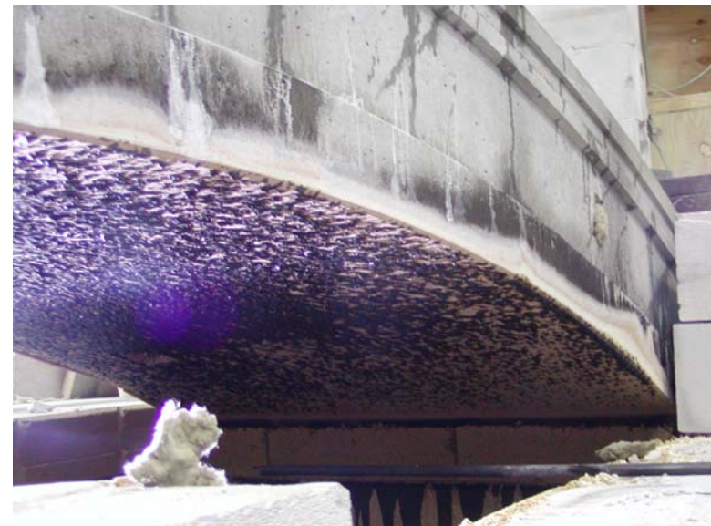
2 BAB-Tunnel-Moorfleet, Hamburg nach dem Lkw-Brand im Jahre 1968
