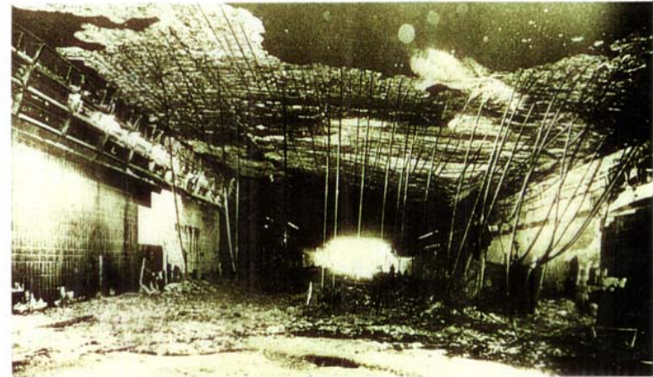
2 BAB-Tunnel-Moorfleet, Hamburg nach dem Lkw-Brand im Jahre 1968
