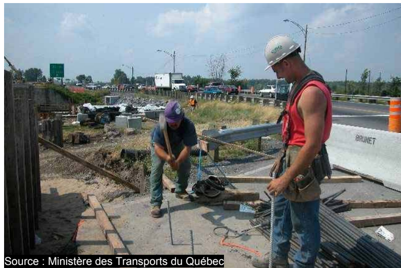
Figure 1 – Un secteur du génie civil en pleine expansion
