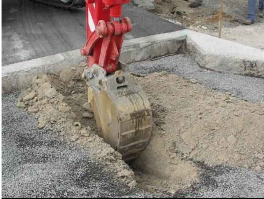
Figure 3 – Excavation de l'assise en GCR.
