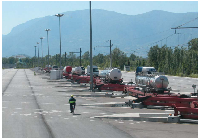
Figure 2 – Aiton terminal, Autoroute Ferroviaire Alpine (© Sétra)
