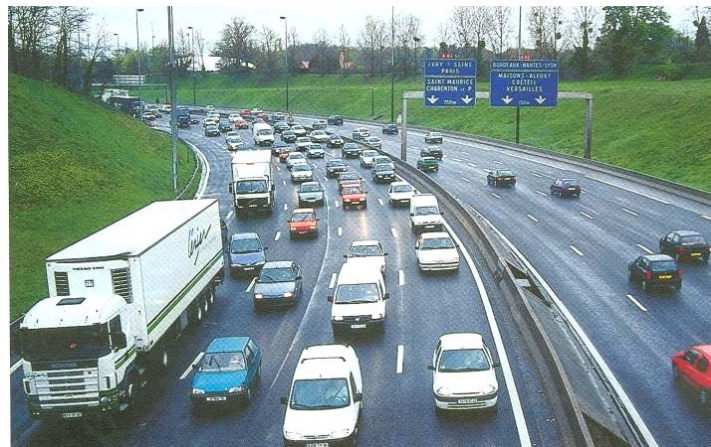
Photo 9 – Tronc commun A4-A86, situation avant aménagement
