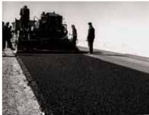
Colas Algérie couche de roulement au Berber-Greene - Route Ghardaïa-El Goléa 8
