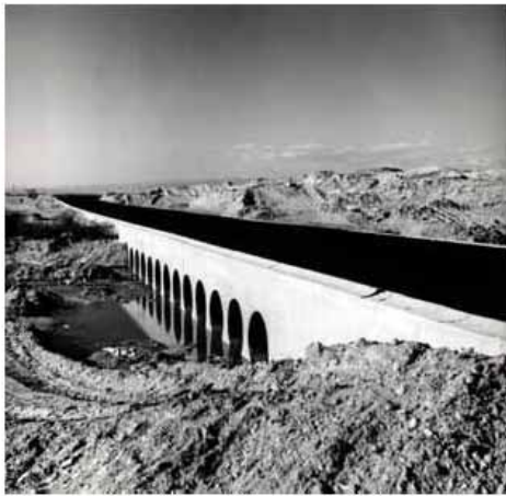
Ouvrage franchissant l'oued Djeddi - Route des Palmeraies 5
