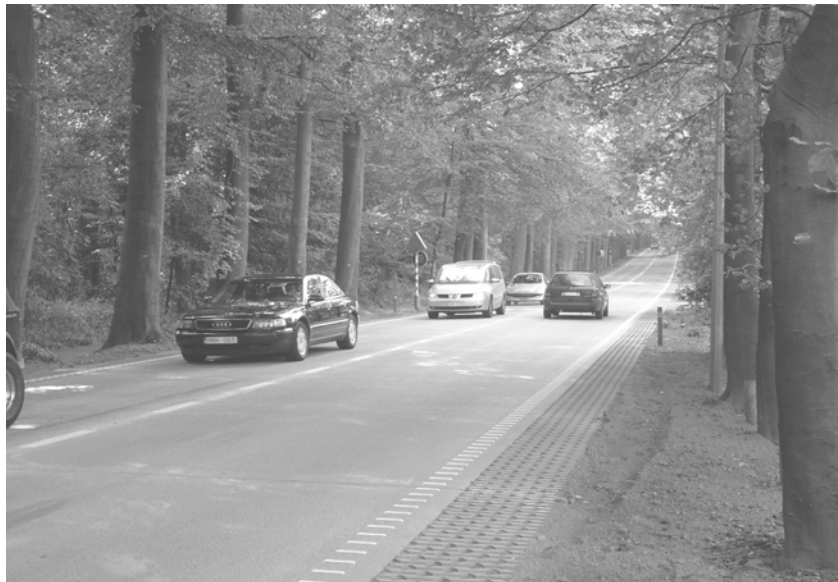
Figure 4 – Recouvrement réalisé en 2003 de la Drève de Lorraine, construite en 1925
