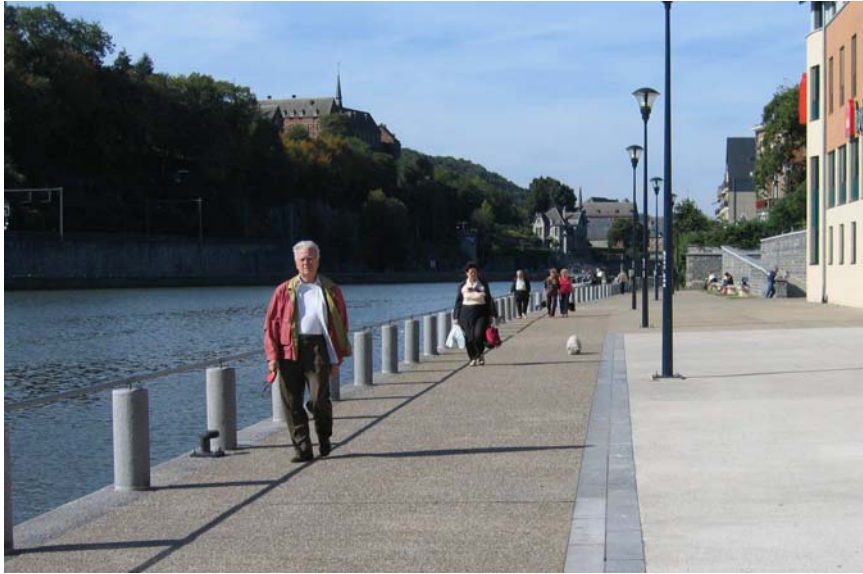
Figure 6 – Exemple de béton coloré désactivé (Dinant – Belgique)
