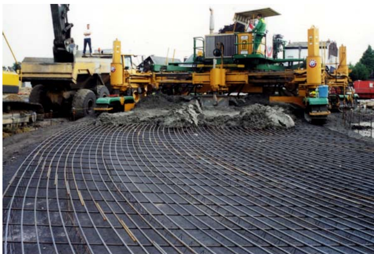
Figure 5 – Giratoire en béton armé continu
