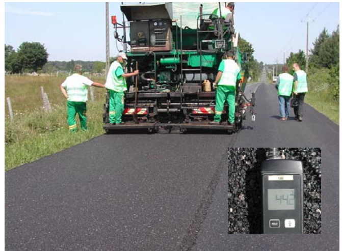
Ecomac : tambour «tiédisseur», application en couche de roulement sur route à trafic moyen, noter l'absence d'émission (crédit photo: Y. Brosseaud LCPC)
