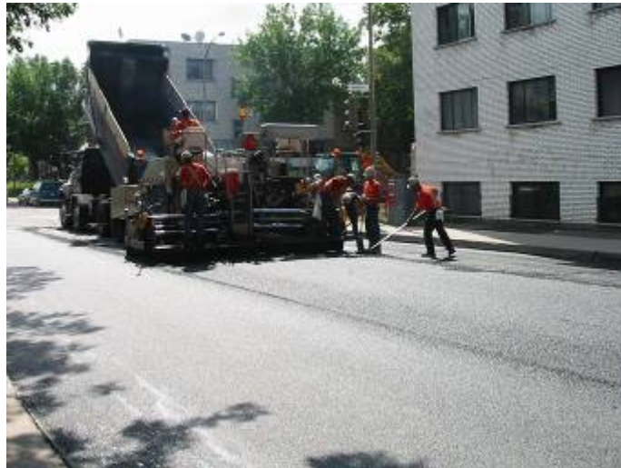
Application d'enrobés tièdes à l'aspha-min ESG-10 PG 70-28, rue Bali à Montréal (Canada), août 2005 (crédit photo :Y. Paquin DJL - EUROVIA)
