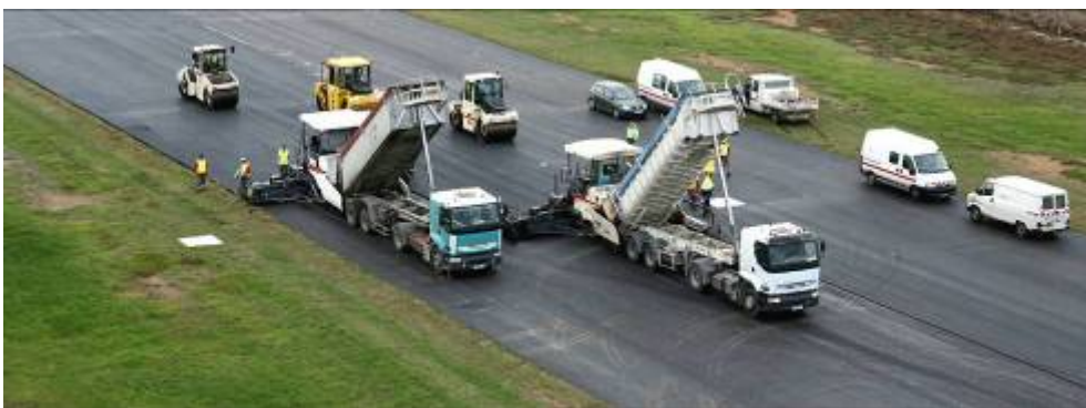
EBT : application de 4500 tonnes d'enrobés tièdes BBA 0/10, aéroport de Candillargues (Dpt 34) (crédit photo : société EIFFAGE Travaux Publics)
