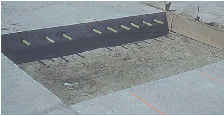
Figure 6 – Zone de réparation de 2 m prête pour la mise en place du béton.
