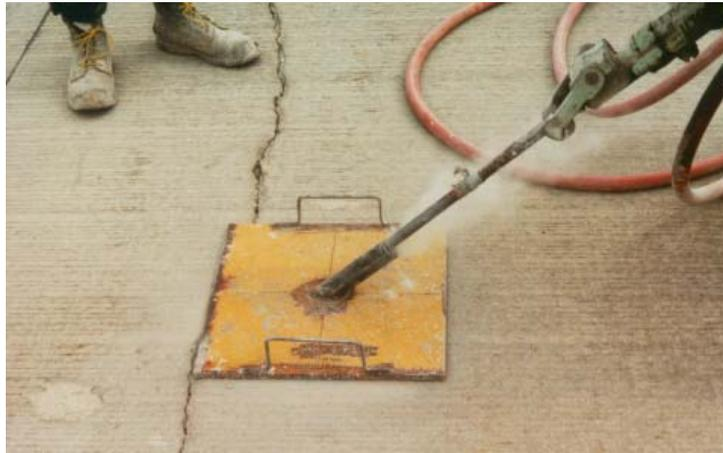
Figure 4 – Perçage de trous pour un agrafage à croisement.
