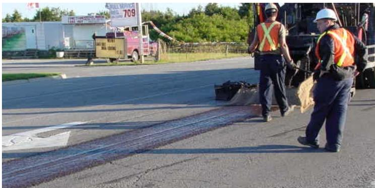
Figure 9 – Pré-traitement d'un faïençage modéré de la ligne médiane.
