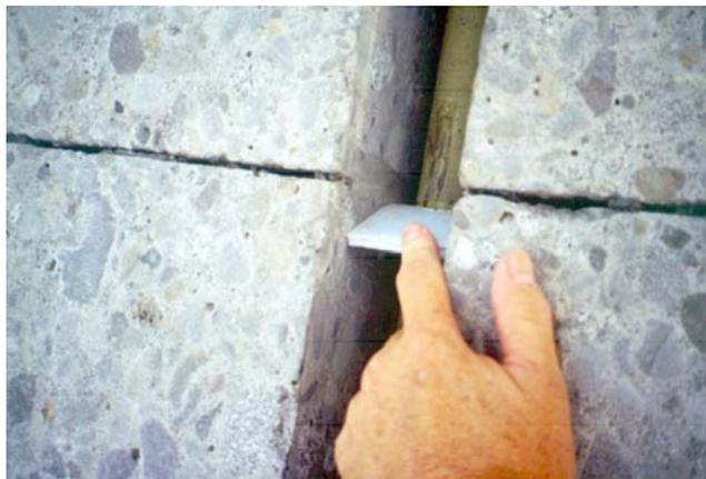
Figure 3 – Mise ne place d'un dispositif d'écartement dans la rainure.
