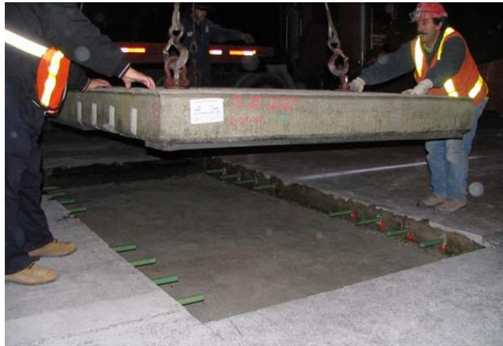
Figure 1 – Installation d'un panneau préfabriqué
