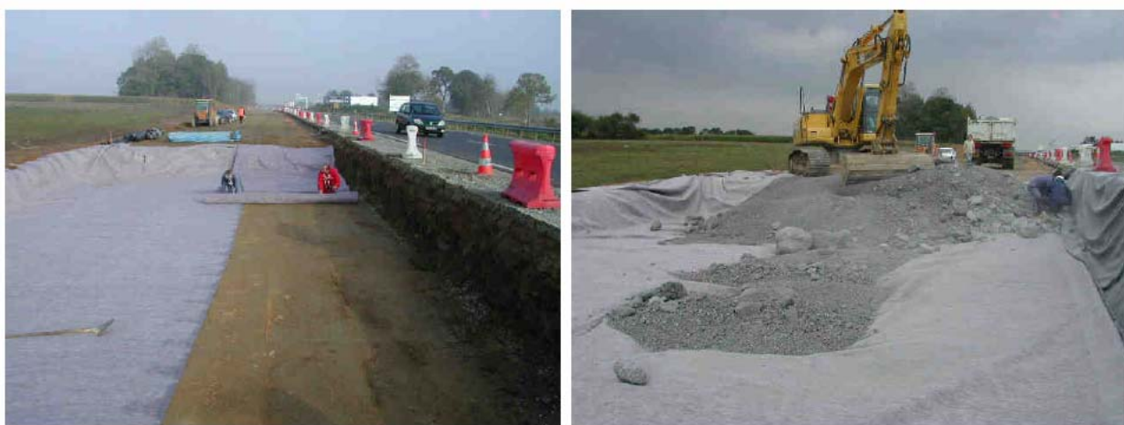
Figure 6 – mise en œuvre de l'étanchéité et des MIOM – chaussée instrumentée RD767
