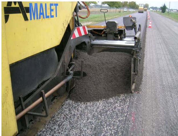
Figure 9 – Mise en œuvre du chantier par demi-chaussée
