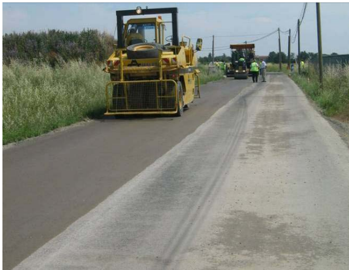
Figure 7 – Mise en œuvre du chantier par demi-chaussée
