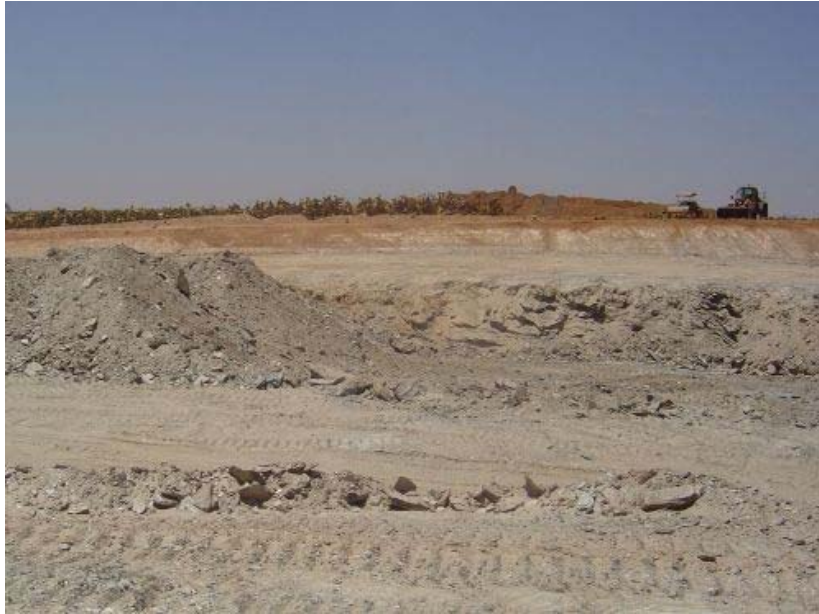
Figure 2. Utilisation de micaschistes à l'état très sec sur un chantier autoroutier au de la région de Marrakech (Maroc).
