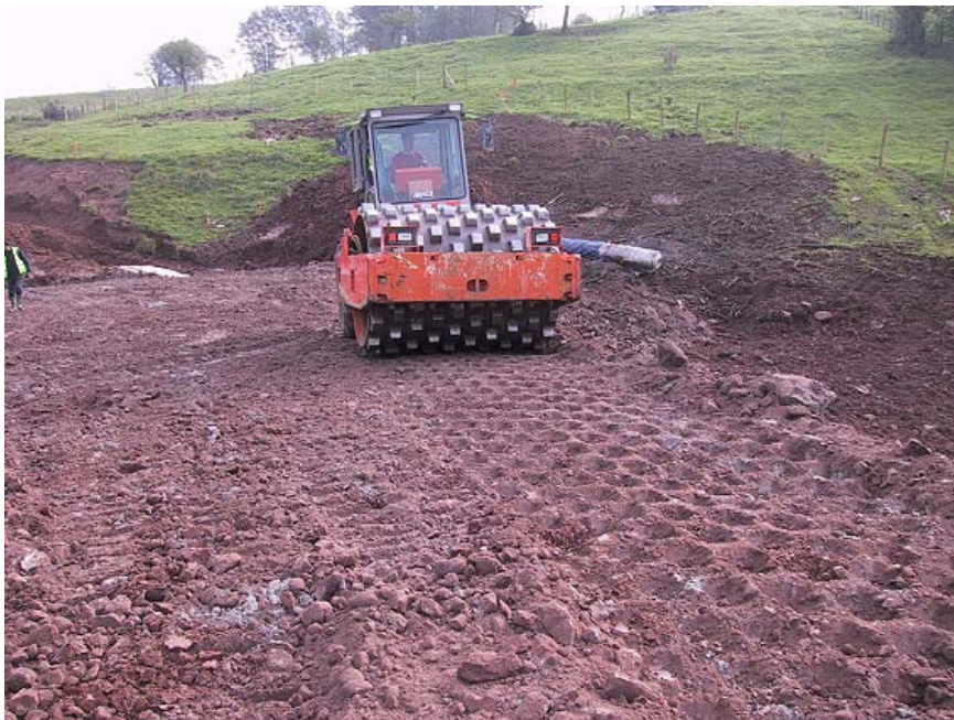
Figure 4. Compactage d'une pelite à l'état sec.
