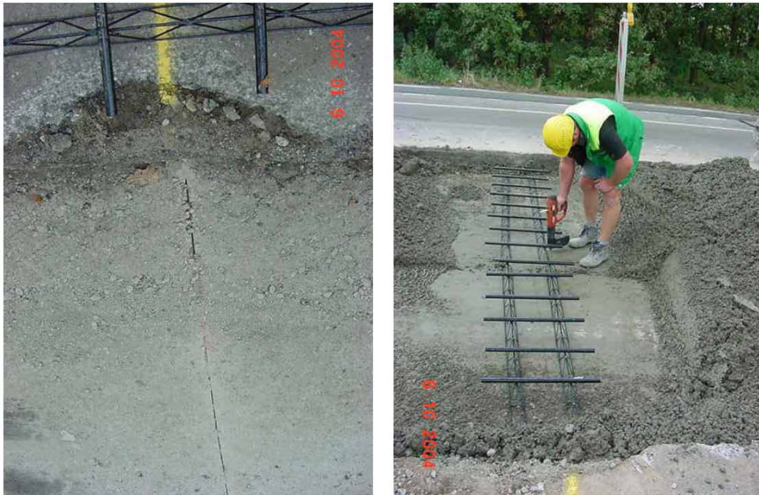
Figure 2 - Incision dans le béton cylindré pour le joint de retrait transversal
