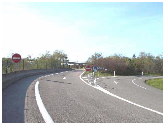
Le sens interdit B1 et la balise J5 dans le divergent sont positionnés côte à côte et flèches au sol.
