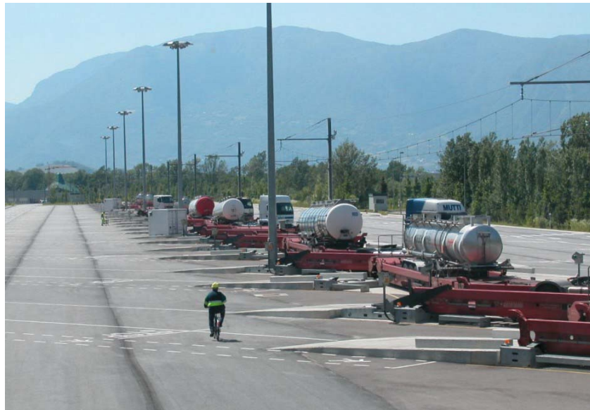
Figure 2 – La plate-forme de Aiton, Autoroute Ferroviaire Alpine (© Sétra)
