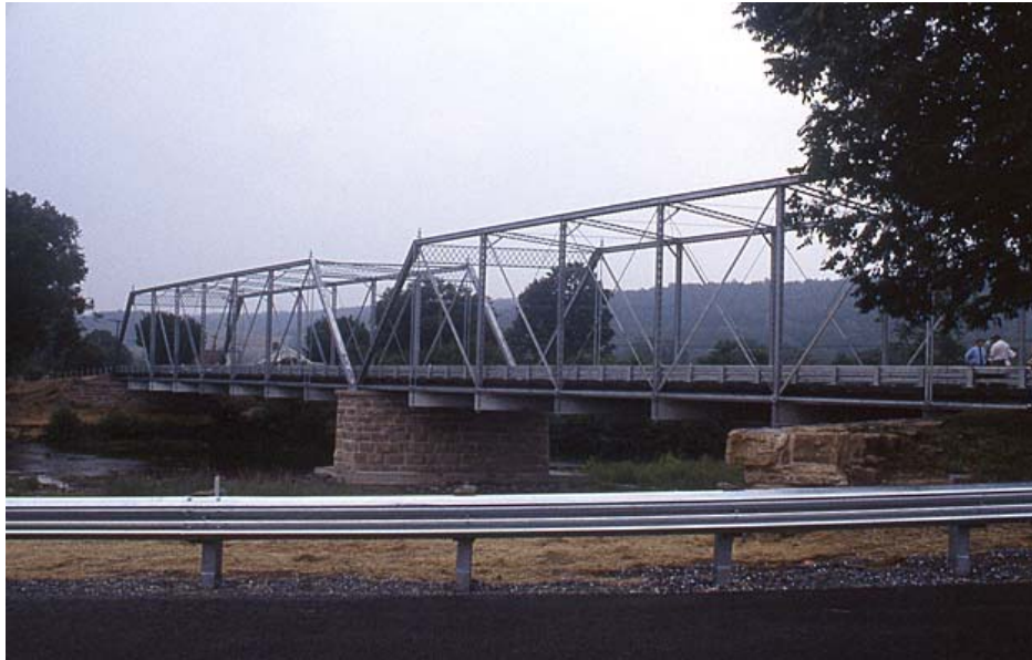
Figure 2 – Le pont Goshen remis à neuf
