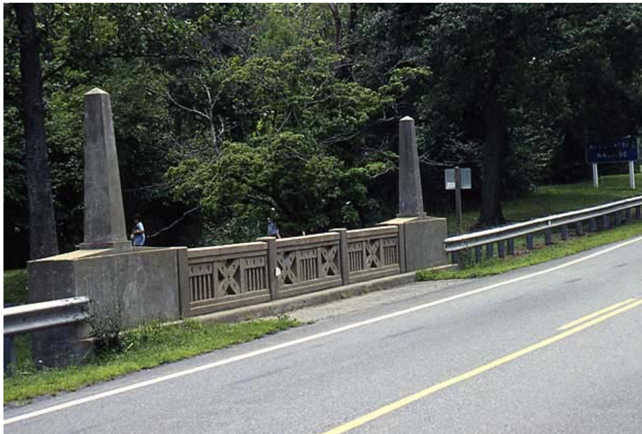
Figure 1 – Rampe et obélisques décoratifs en béton, ouvrage n° 1002 – comté Appomattox
