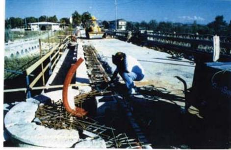
Photo n° 7 – Le pont le long de la RD 85 “Castelnuovo Scrivia – Alluvioni Cambiò” dans la localité Castelnuovo Scrivia – Les travaux de réhabilitation du plan routier
