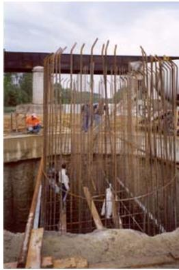
Photo n° 16 – Fondations en puits des piles du nouveau pont le long de la Départementale 77
