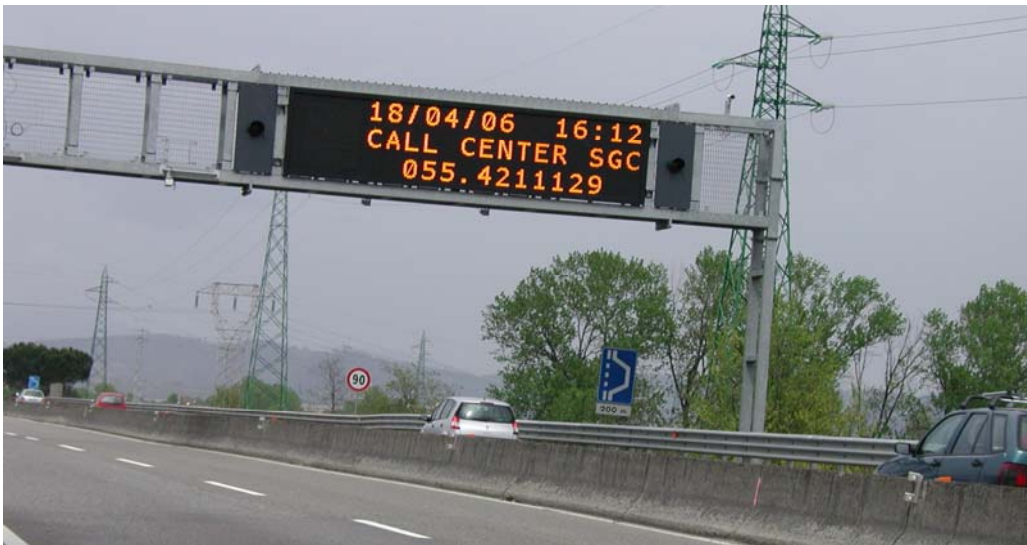
“Figure 6 - Les panneaux à messages variables installés le long de l'infrastructure”
