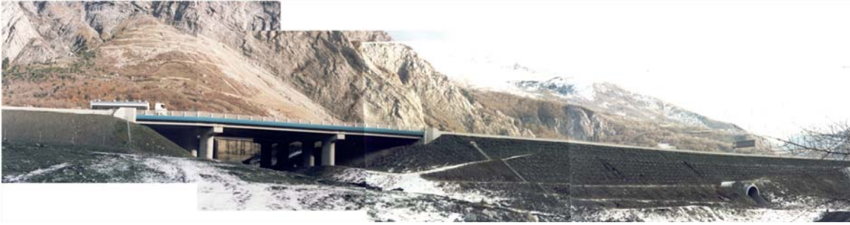
Figure 5 -: Ouvrage OH90 sur le secteur du Rieu Sec (PI91 à droite).
