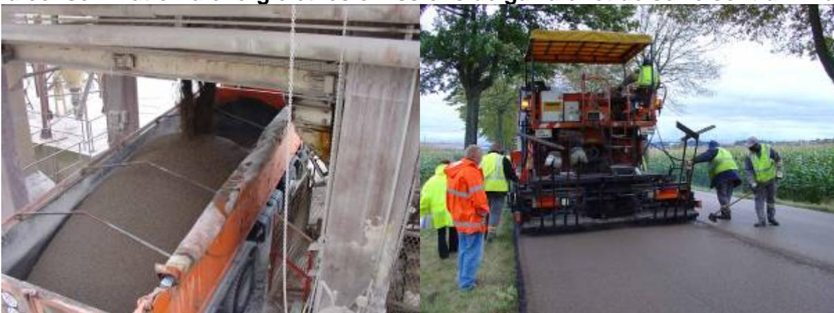
Photo 8 et 9 - Chargement d'un camion à la centrale de fabrication mise en oeuvre des enrobés correspondants sur une route départementale très circulée.
