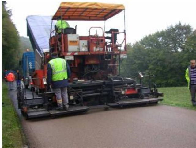
Photo 11 - Octobre 2003, mise en œuvre des enrobés 0/6 à Ligsdorf.
