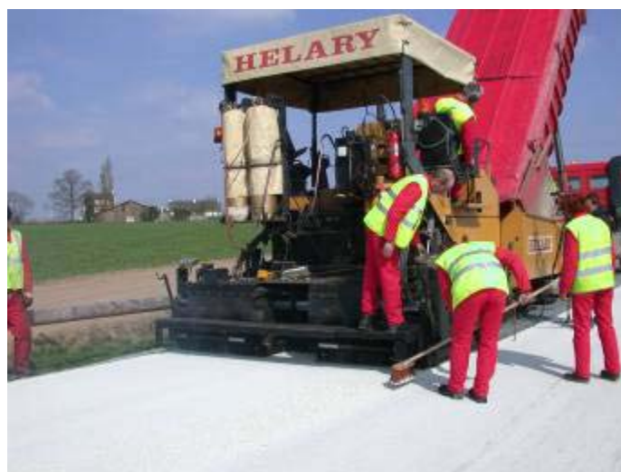
Photo 5 - Mise en œuvre des tous premiers enrobés au liant végétal (couleur blanche)
