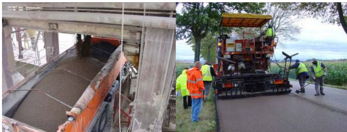
Photo 3 et 4 - Chargement d'un camion à la centrale de fabrication mise en oeuvre des enrobés correspondants sur une route départementale très circulée.
