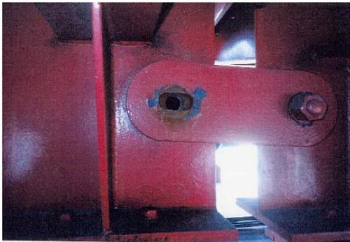
c) Fracture d'un boulon de serrage
