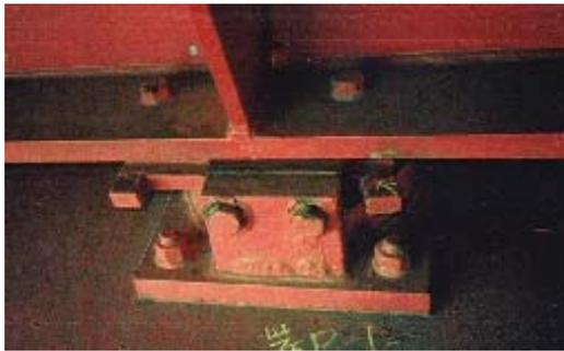
a) Fracture au niveau d'une fixation de poutre
