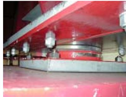
Fig. 10 - Système d'isolation anti-sismique plancher-tablier utilisant des paliers glissants
