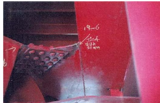
d) Dégât au niveau d'une plaque gousset
