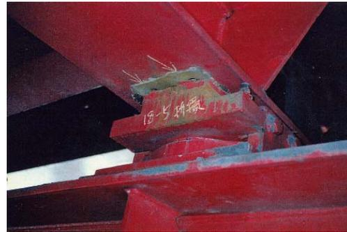
b) Fracture de l'ensemble des boulons d'une poutre
