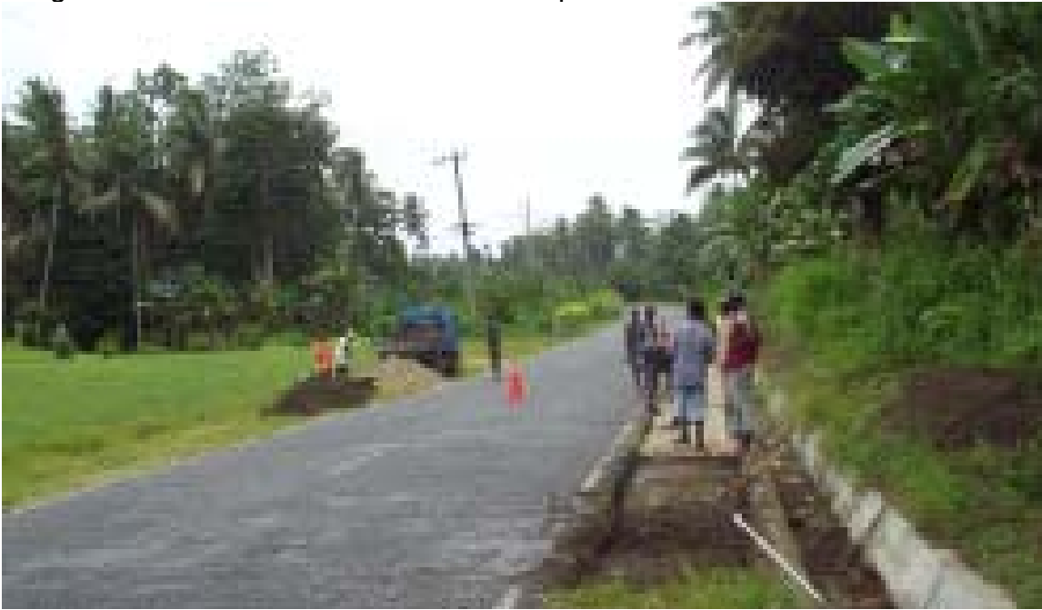
Image 2 La mise en chantier la route au Papua New Guinea
