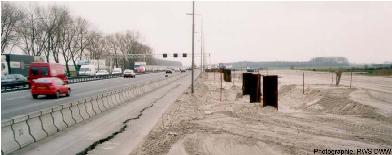
Figure 2 - Fissures du revêtement de la chaussée lors d'un projet d'élargissement de la route
