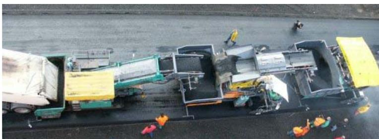
Figure 3 – Colonne de pose selon technologie 2 avec deux finisseurs
