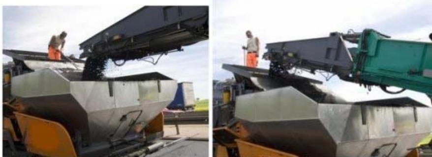
Figure 7 – Chargement du finisseur à liant ; à gauche : liant, à droite : revêtement
