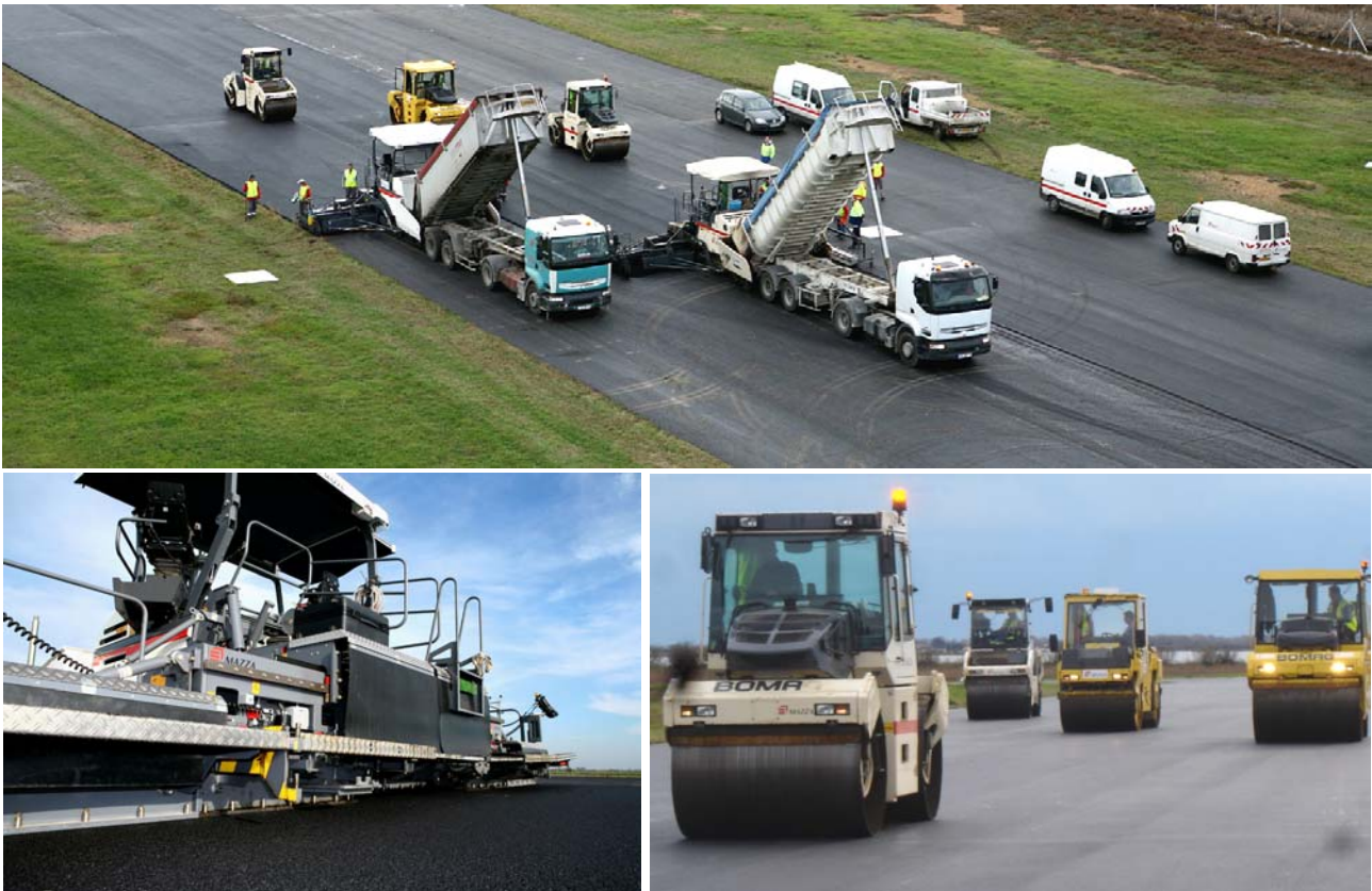
Figure 9. Exemple de chantier LEA ® de 3100 tonnes (aérodrome vers Béziers, France).
