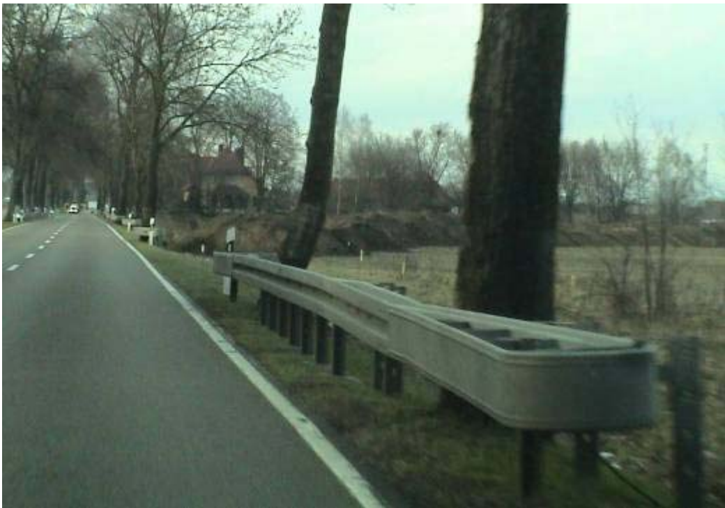
Figure 11 - Rails de sécurité absorbant l'énergie placés à proximité d'arbres
