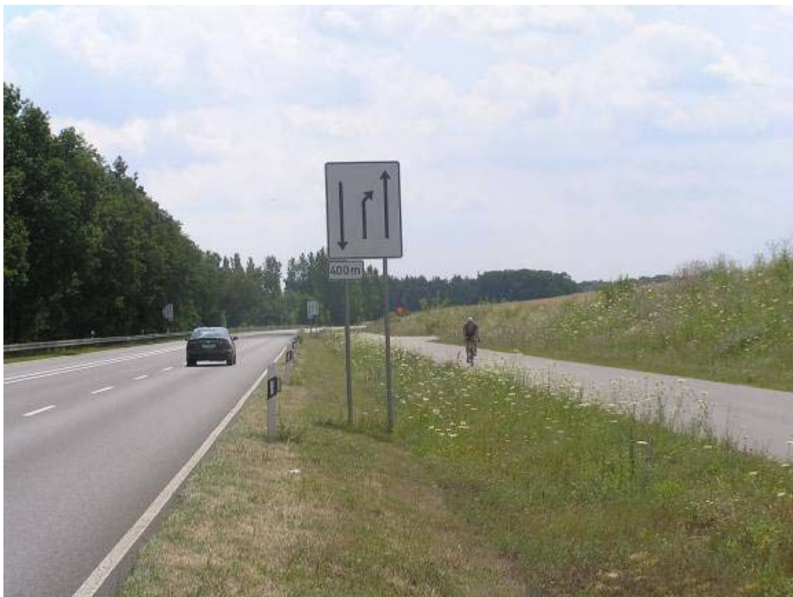
Figure 4 - Route fédérale moderne à trois voies avec séparation du trafic lent
