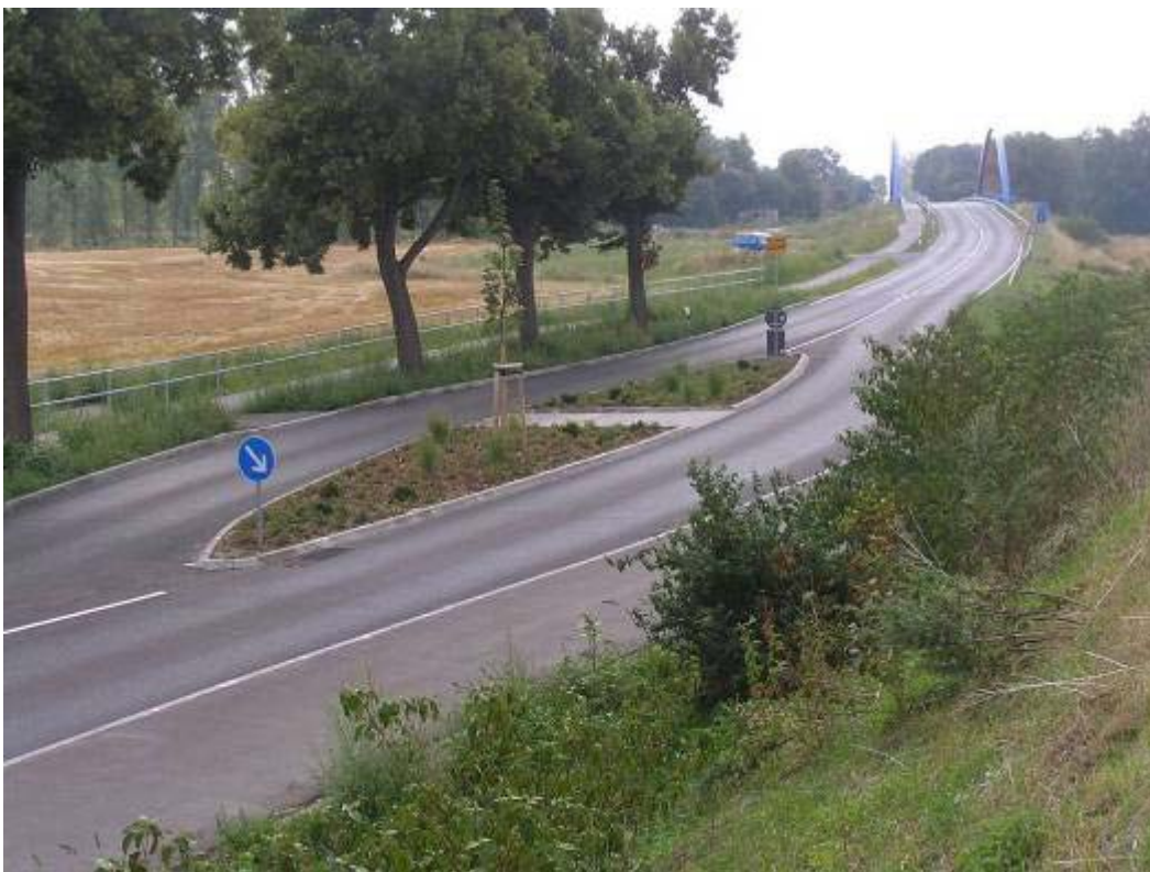
Figure 3 - Séparation du trafic non motorisé par un îlot de refuge
