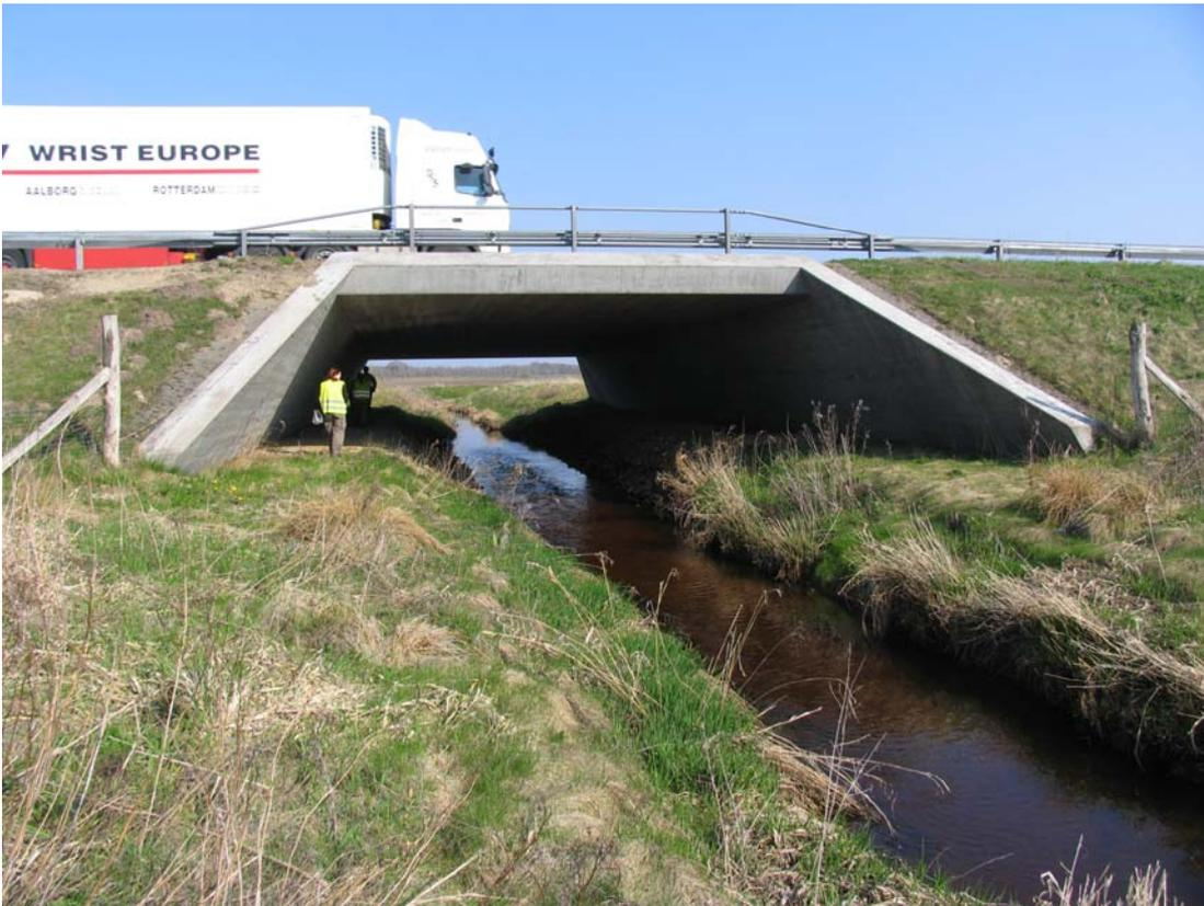
**Figure 6 - Passage souterrain humide. Le passage à faune a été construit avec des talus sur chaque rive. Les talus ont une surface plane sur le dessus et des côtés en pente vers le cours d'eau.**
