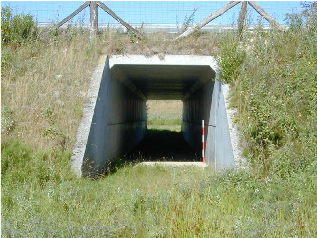
**Figure 7 - Souterrain sec avec l'entrée la plus proche donnant sur une dépression artificielle, sachant que la surface de la route est construite au même niveau que les zones environnantes.**
