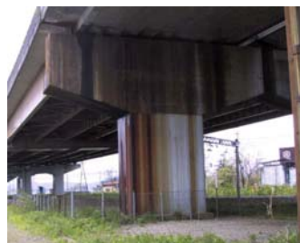
(b) Grâce au renforcement, pas de dégâts sur la pile Séisme du Chûetsu, dans le département de Niigata (2004)
