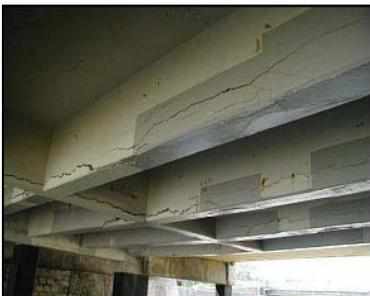
Photo 1. Dégradation par le sel
