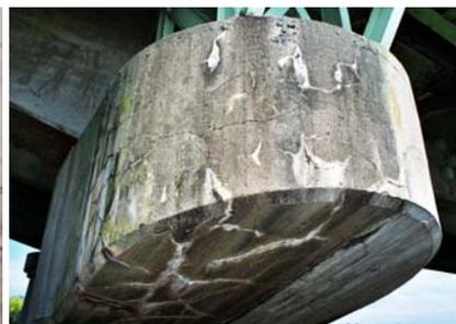
Photo 3. Etat de dégradation dû à l'alcali-réaction
