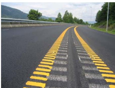
**Illustration 2 - Exemple de ligne large centrale sur route à deux voies**
