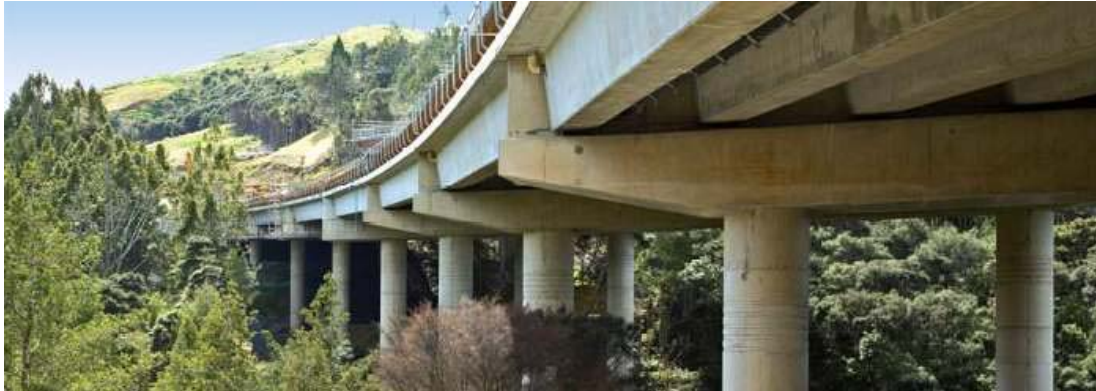
Figure 4 - l'éco-viaduc partiellement terminé montre la petite surface d'impact créée durant la construction afin de préserver l'écosystème existant sous la structure
