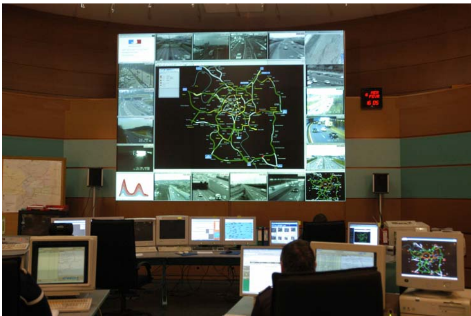
Figure 8 – Le mur d'images du centre de coordination du trafic de Créteil
