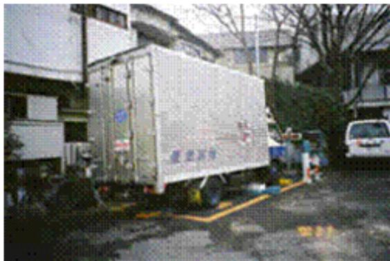
Photo 3 – Essai d'un système de chargement de poche (arrondissement de Nerima, Tokyo)
