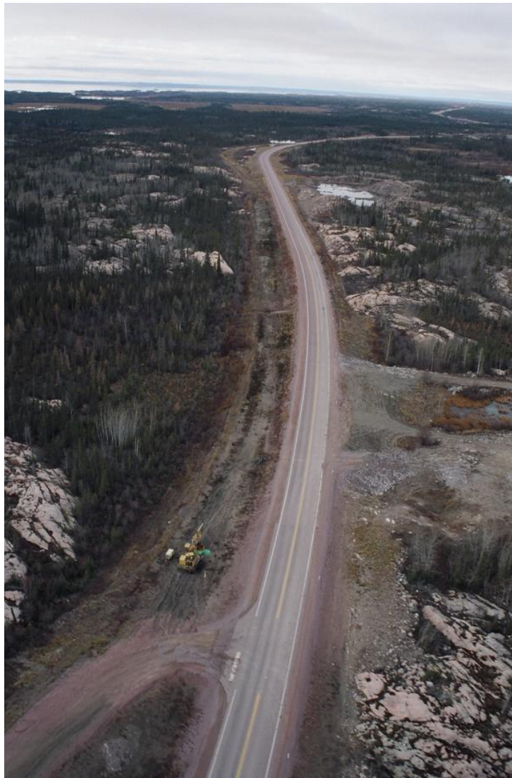
Figure 3 – Route de Yellowknife après sa reconstruction
