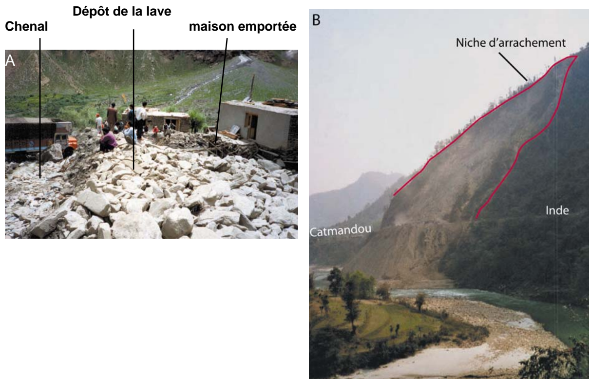
Figure 5 - Deux événements de coupure de route stratégique dans l'Himalaya. A : Lave torrentielle coupant la route transhimalayenne donnant d'accès au Cashmire indien (d'après [16]). B : Glissement de Krisnabir coupant la route d'accès à Katmandou depuis l'Inde.
