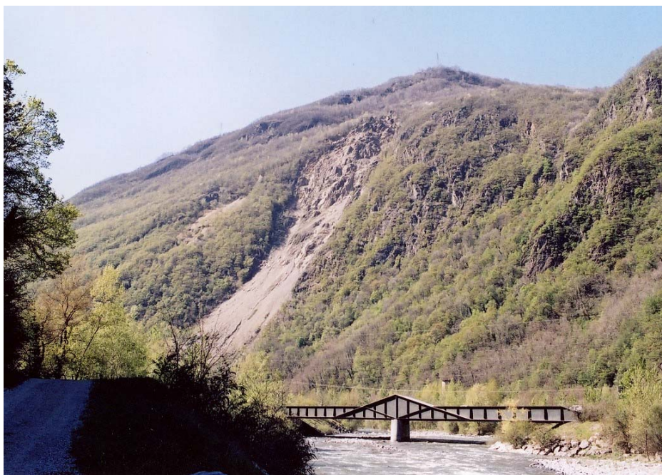
Figure 2 – Vue depuis l'amont : le pont de la nouvelle route sur la Romanche et le couloir des Ruines
