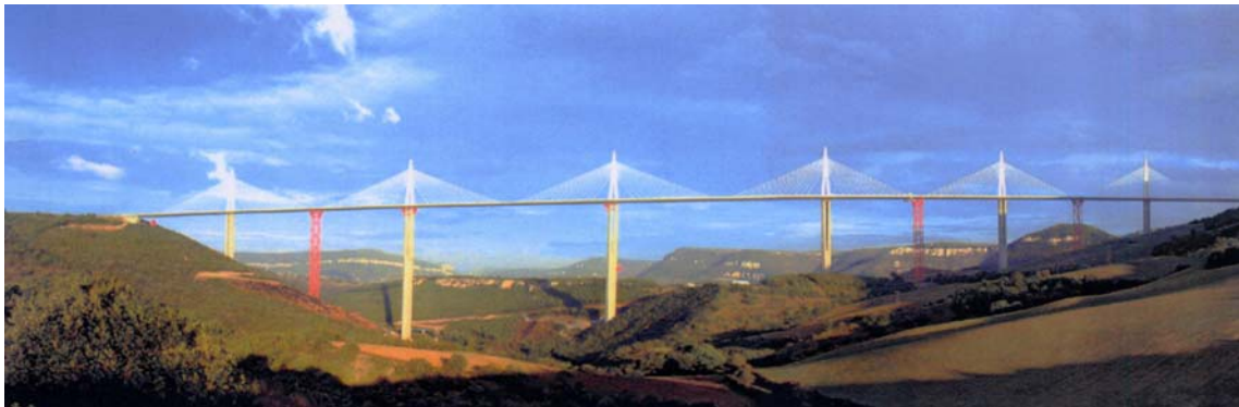
Photo 1 : Vue générale du viaduc de Millau en fin de construction
