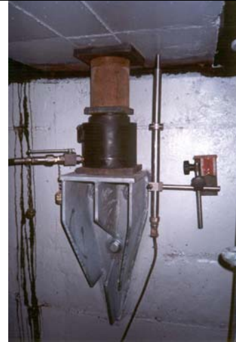
Vérin sur console métallique sous poutre en béton
