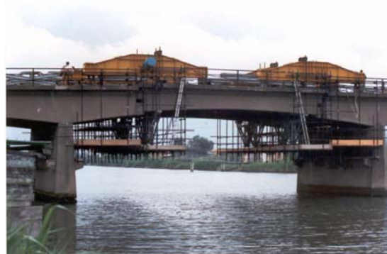
Soulèvement d'une travée en porte à faux
