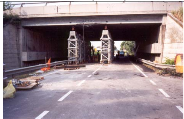
Étayage d'un ouvrage percuté à l'aide de tours en treillis
