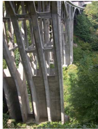
Détail d'une pile
