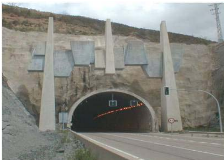
Figura 11 - Vista de la boquilla de entrada
