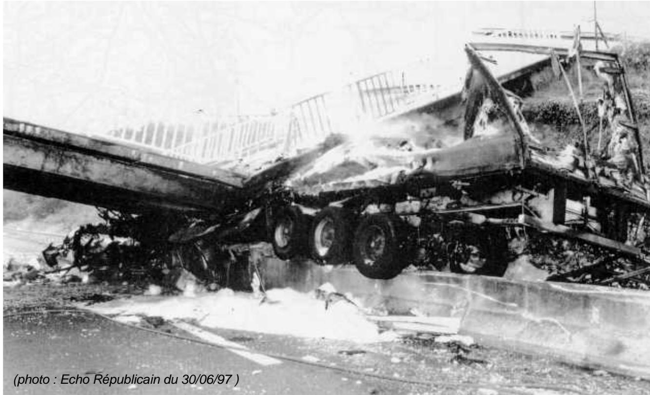
Un semi-remorque roulant à 90 km/h détruit 4 poteaux de la palée de rive d'un pont (1997) – A11, France
