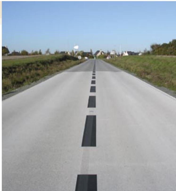
Photo 6 : Aspect du revêtement après nettoyage à l'eau sous pression
