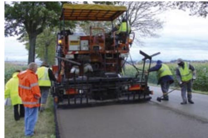
Photo 4 : mise en oeuvre des enrobés
